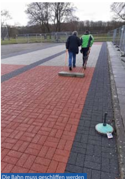
Die Bahn muss geschliffen werden
