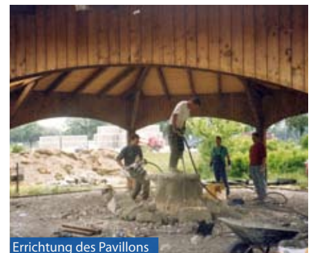
Errichtung des Pavillons
