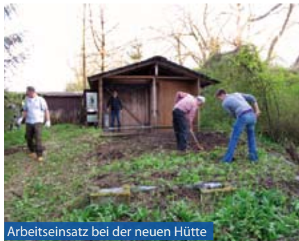
Arbeitseinsatz bei der neuen Hütte
