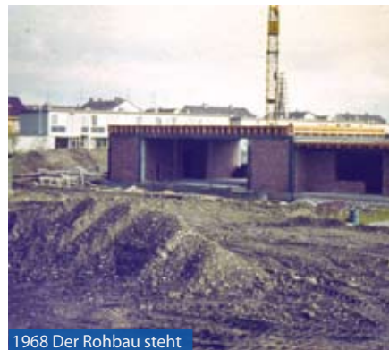
1968 Der Rohbau steht
