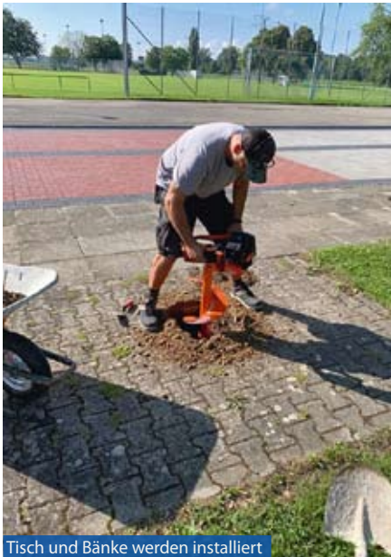
Tisch und Bänke werden installiert
