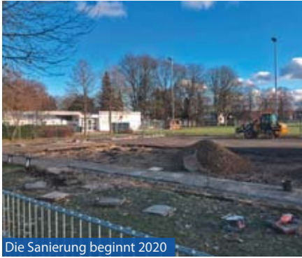
Die Sanierung beginnt 2020
